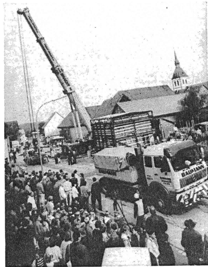
Ein gutes Jahr nachdem das kleine Querdeelenhaus aus Rösebeck im Stahlkorsett komplett nach Detmold transportiert wurde, kann es jetzt wieder eröffnet werden.
